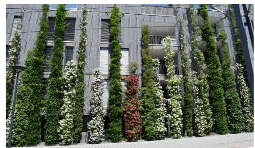
Abbildung 23 Bodengebundenen Fassadenbearünung (linear mit Kletterhilfe)
