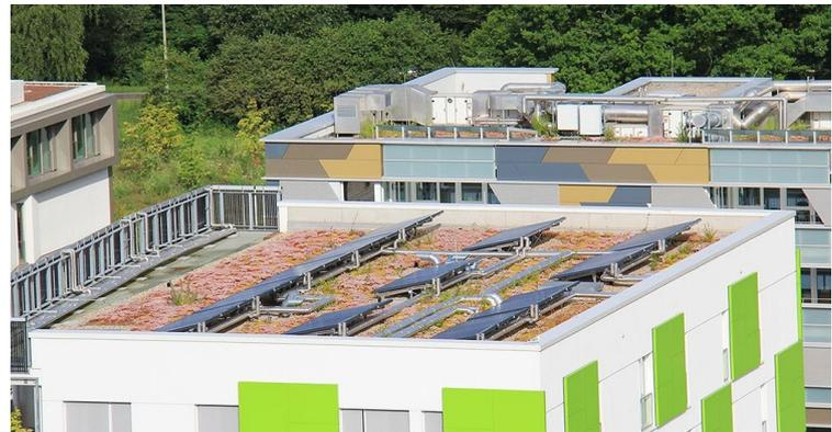
Abbildung 20 Extensivbegrünung in Kombination mit solarer Energiegewinnung
