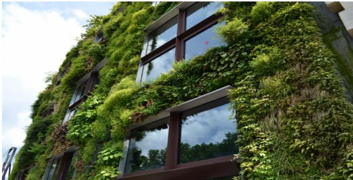
Abbildung 26 Fassadenbegrünung mit vollflächigen Vegetationsträgern
