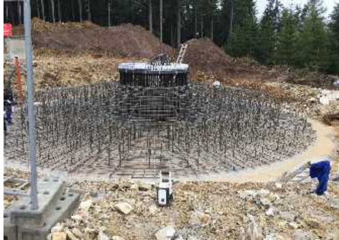
Abbildung 7: Fundamentarbeiten am Herrenstein
