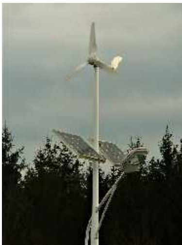
Abbildung 9: Windrad und Photovoltaik zur Straßenbeleuchtung
