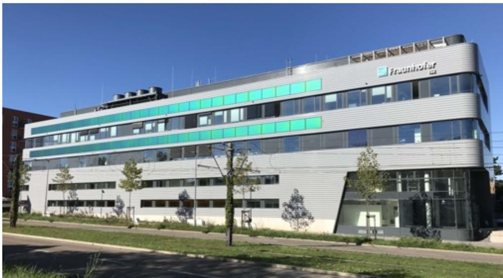
Abbildung 51: Gebäudeintegrierte PV-Module am Fraunhofer ISE (Quelle: <https://www.ise.fraunhofer.de/de/presse-und-medien/presseinformationen/2023/farbige-pv-module-mit-fraunhofer-ise-patent-erreichen-marktreife.html>, Zugriff: 22.11.2023)
